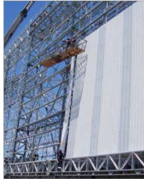
PLANCHA PVC DV-4 EN AMBIENTES AGRESIVOS, AUTOEXTINGUIBLE
