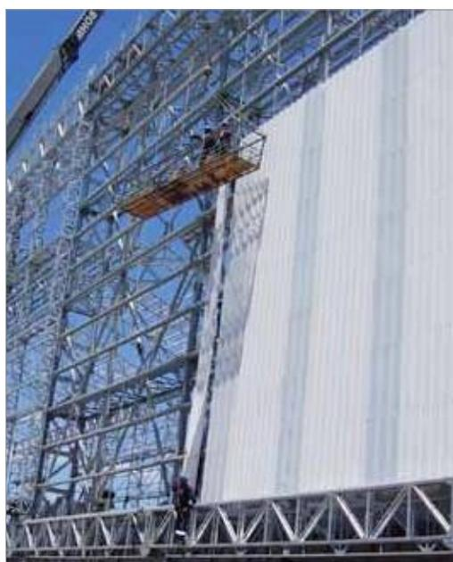
Las planchas de PVC, para cubiertas y revestimientos, están desarrolladas especialmente para proyectos en ambientes corrosivos, húmedos, salinos y expuestos a condiciones climáticas extremas. Su alta resistencia las convierte en una excelente solución para industrias como la alimentaria, minera, agropecuaria, acuicultura, químicas, entre otras.
